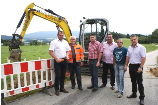
Von links: Bürgermeister Roland Freund, Bauhofleiter Josef Sommer, Josef Markl und Paul Czegenyi (Telekom), Christian Dambeck (B&D Tiefbau), Ludwig Jakob (Breitbandpate)
